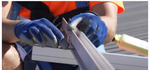
**POSICIONA EL MÓDULO SOBRE LOS RAILES. Y FIJA LA GRAPA LA PIEZA 833-TSU-01 PARA UNIR RAIL A TRIÁNGULO.**
