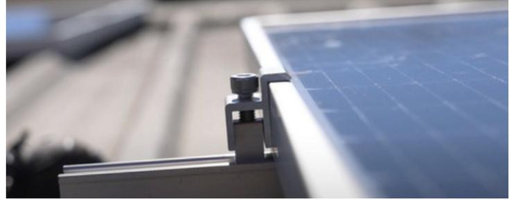
**FIJA LA GRAPA INTERMEDIA 833-GI Y APRIETA. RECUERDA PONER LA PLACA EQUIPOTENCIAL. (PAR DE APRIETE TORNILLOS = PRESOR 7 NM, M8 HEXAGONAL 20 NM, M10 HEXAGONAL 40 NM)**
