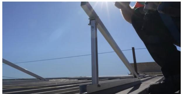
**UTILIZA LA PIEZA 833-TSU-01 PARA UNIR RAIL A TRIÁNGULO.**
