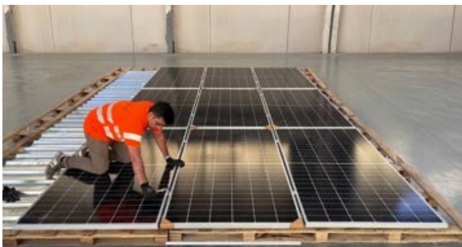
Imagen 5: CARGA DURANTE APRIETE – PROHIBIDO
